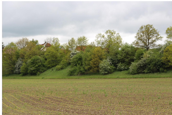
Bild 2: Die 10 Meter hohe Erosionskante
