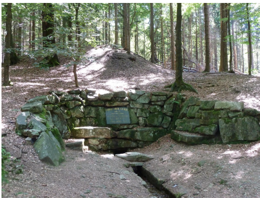
Bild 1: Ehemaliges Stollenmundloch mit Quelfassung der Saale, darüber eine Halde
