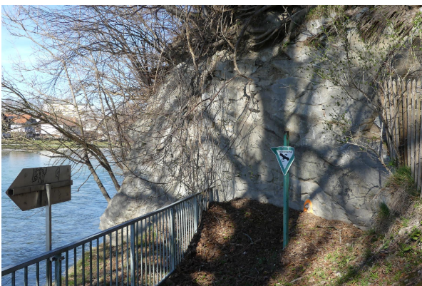
Bild 3: Baustein-Schichten am Isarufer
